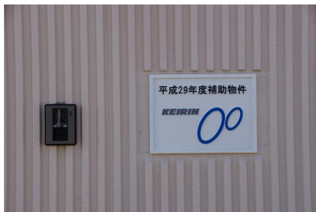
玄関入口横に設置している標識
