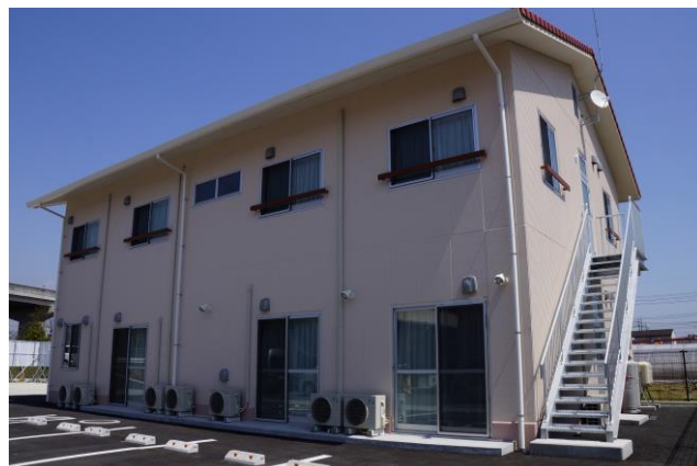
南西方向からの外観
